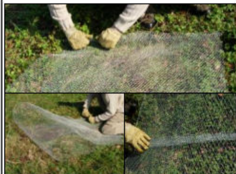
Figure 2 : Replier les bords du treillis pour former un cylindre .
